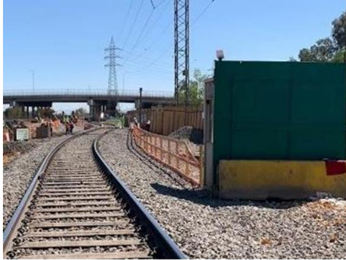
Puente Zanjón Aguada, E. Central/Cerrillos
