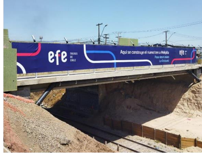
Paso Vehicular Lo Errázuriz, Cerrillos
