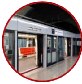
Puertas de andén
