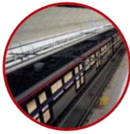
Electrificación en altura (1.500V DC)
