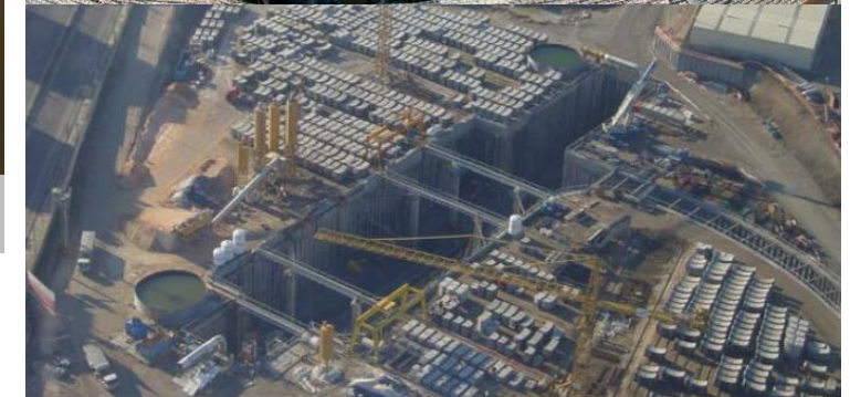
Pique de ataque ingreso TBM
