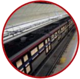
Electrificación en altura
