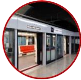
Puertas de andén
