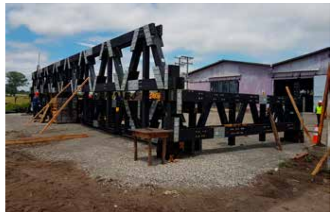
Armado de puente modular prefabricado en la planta de Yumbel
